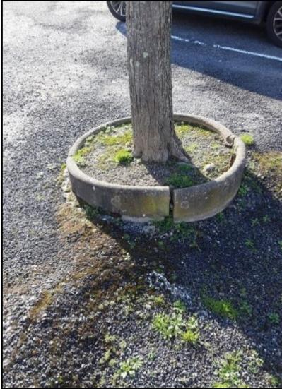
Figure 1 : Soulèvement du revêtement d'un parking par les racines d'un *Acer saccharinum*
